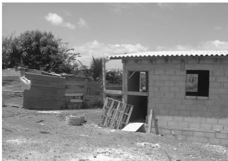
Woningverbetering in de wijk Soto, Curaçao; links de huidige woning en rechts de nieuwe woning
